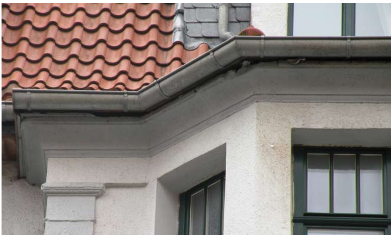
Erhalt von Einflugmöglichkeiten an der Altbaufassade
