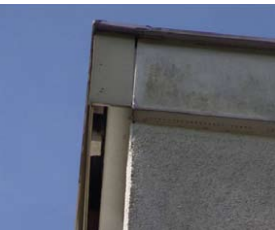
Quartier hinter der Dachverblendung
