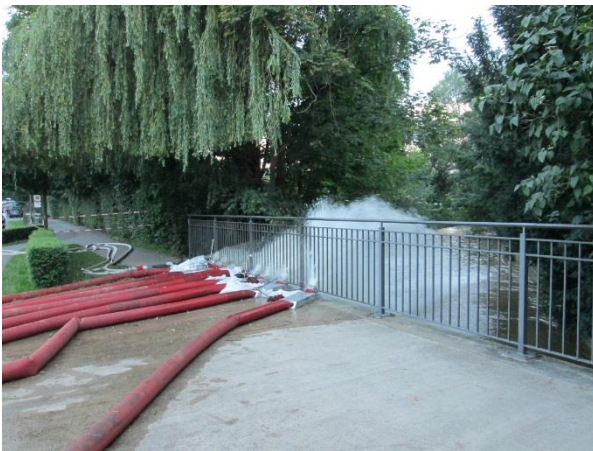
Brücke Mittelriede Riddagshausen
