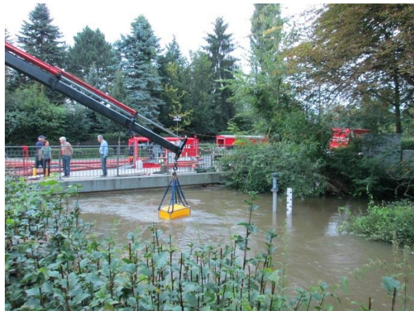
Brücke Mittelriede Riddagshausen
